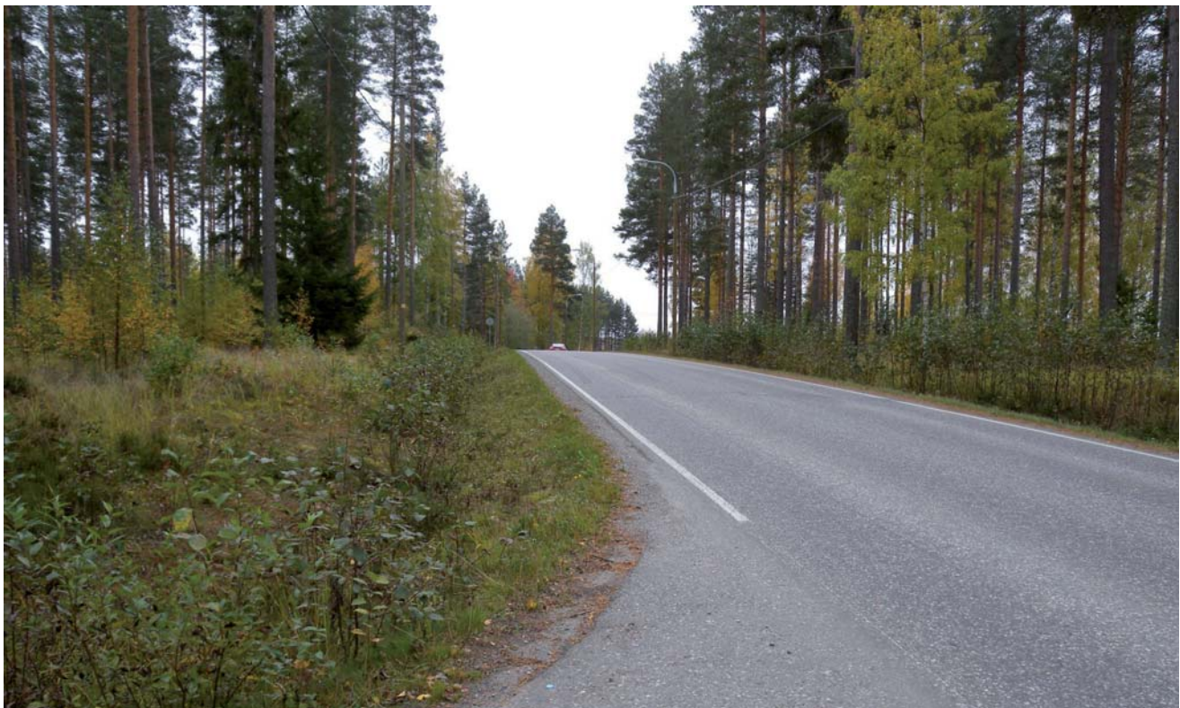
Kuva 30. Näkemät ovat huonot Puntarikoskentiellä hautausmaan kohdalla.
