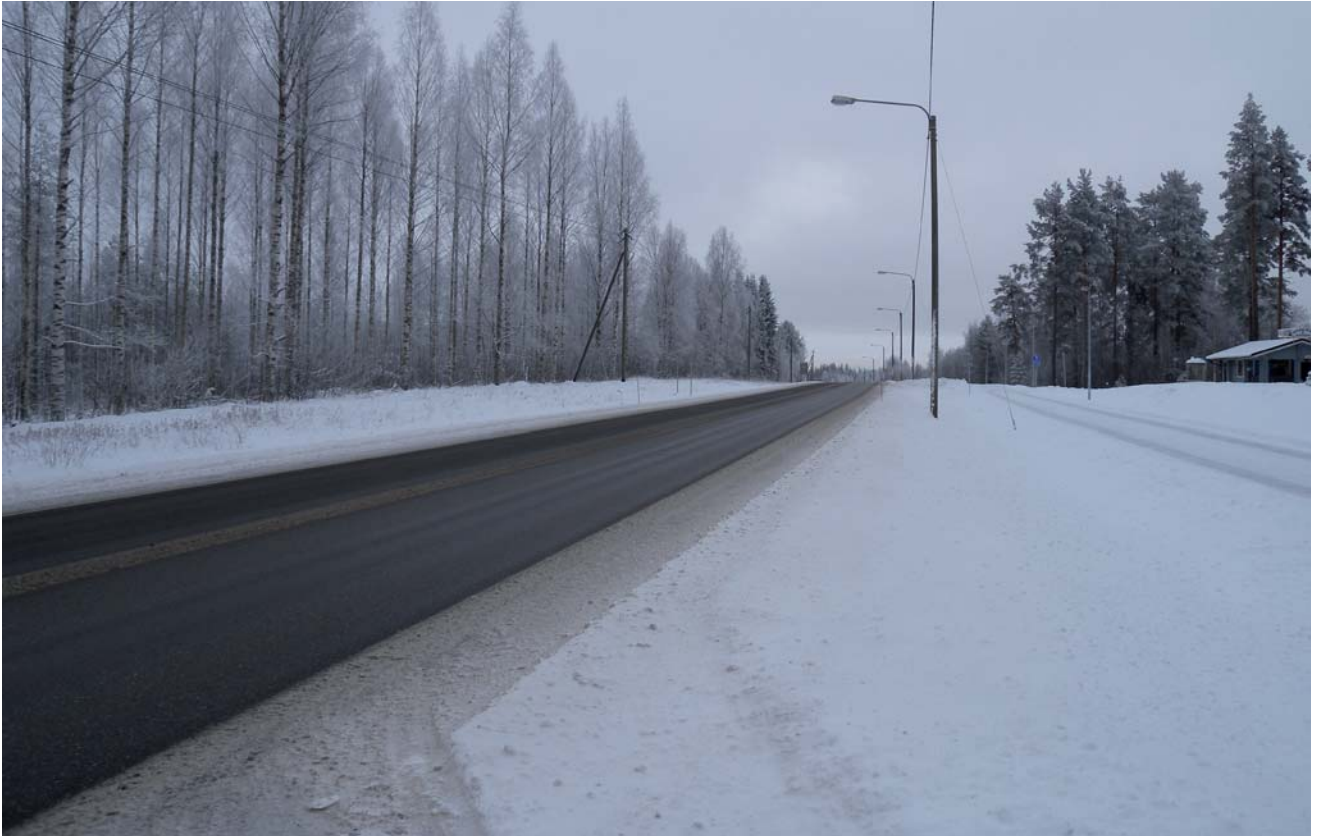
Kuva 22. Vesitornin kohdan levähdysalueen liittymien näkemät ovat puutteelliset.
