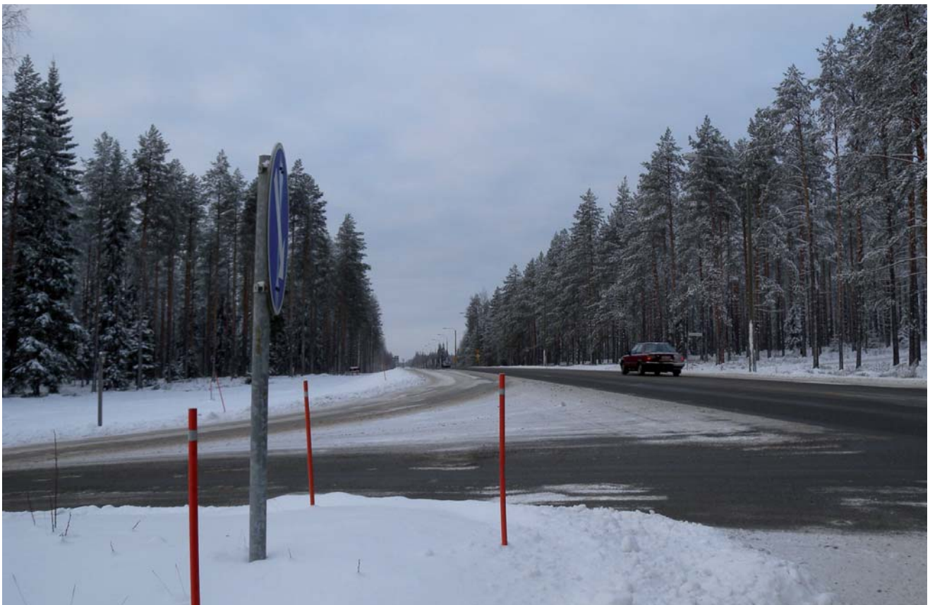
Kuva 26. Kantatiellä 73 oleva Paiholantien liittymä koetaan vaaralliseksi varsinkin talviaikaan.
